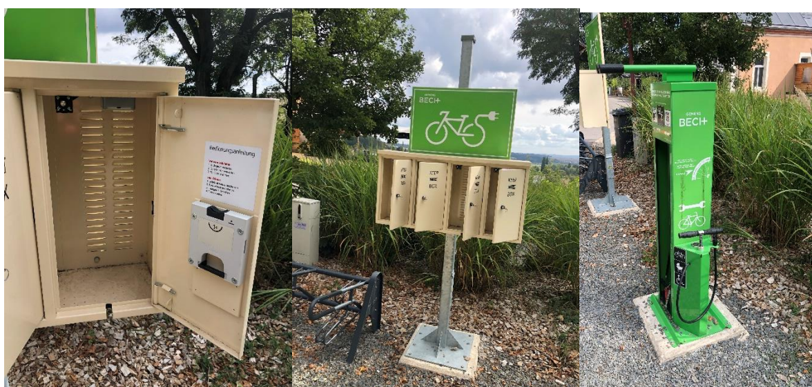
Station de chargement pour pedelecs et de réparation pour vélos à Bech
